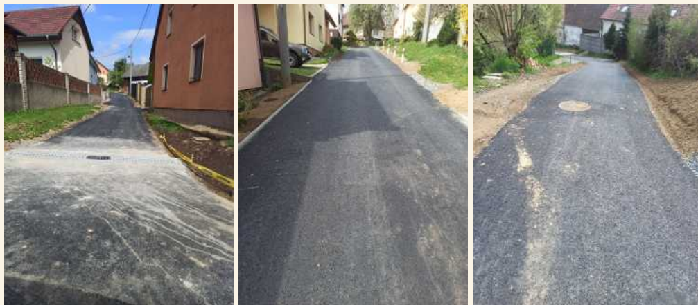
Fotky hotové kanalizace a opravených místních komunikací
